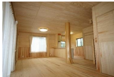
特許取得 化粧パネル工法【天井・壁 パネル】
