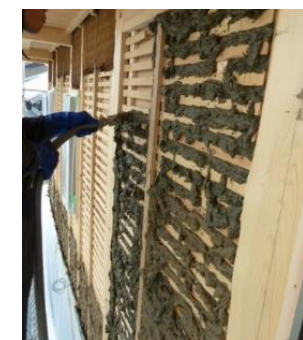
土壁塗りは圧出ポンプを使用する独自工法です
