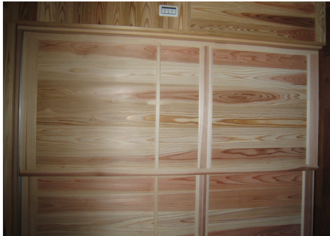
C、D：吊り戸 杉板建具
