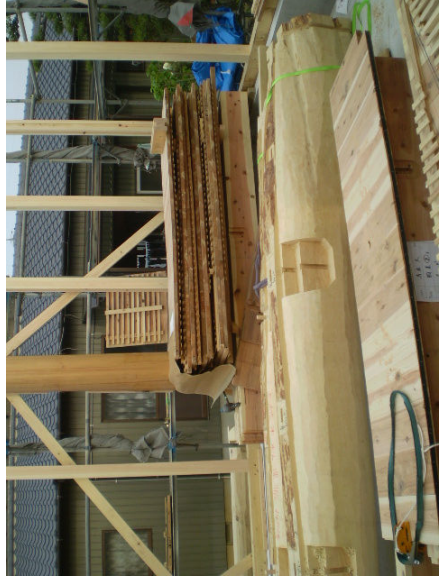
建前時に取付待つ 土壁パネル（工事期間短縮工法）
