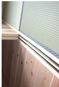
下戸車方式の建具にはアルミレール埋め込み（バリアフリー）
