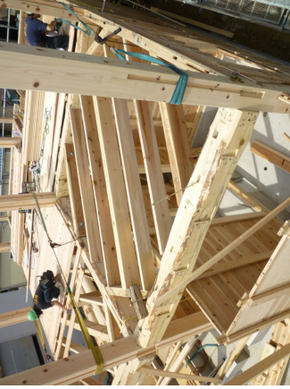
2階梁（オブリーク工法）地震対策工法・取付風景
