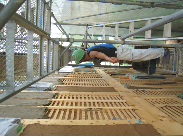
土葺き屋根瓦葺き（断熱工法+温度・湿度調整工法） 風景（杉皮施工はオプションです）
