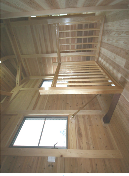
室内土壁パネル（工事期間短縮工法）完成風景
