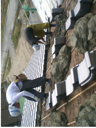
土葺き屋根瓦葺き（断熱工法+温度・湿度調整工法） 風景（杉皮施工はオプションです）
