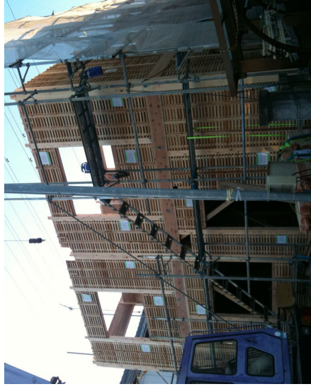
土壁パネル（工時期間短縮工法）を取付けた風景
